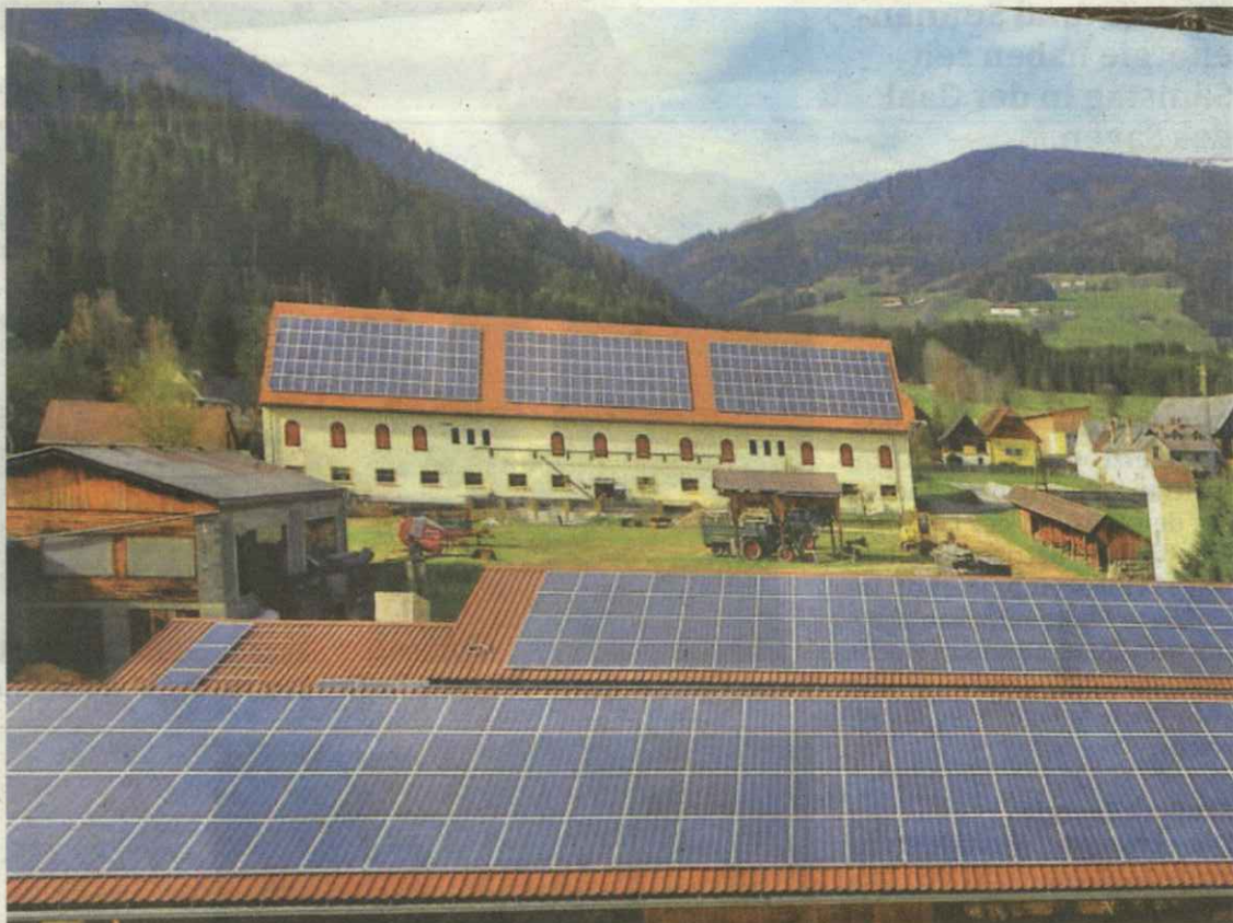
Imponierend: 900 Quadratmeter Dachflächen Photovoltaik als Energielieferant in der Gaal.
